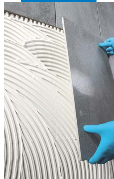
Posa di piastrelle di grande formato su blocchi di calcestruzzo alleggerito
