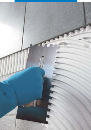
Stesura di Ultramastic 5 sul supporto
