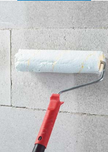
Applicazione del primer sul supporto in blocchi di calcestruzzo alleggerito
