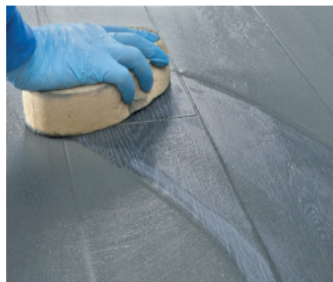
Pulizia e finitura delle fughe con spugna di cellulosa dura
