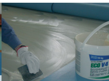
Applicazione di Ultrabond Eco V4SP - Casa di Riposo San Martino - Italia
