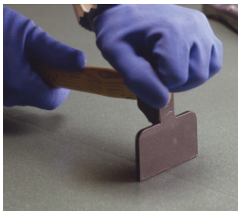
Massaggiatura dei teli sulla giunta
