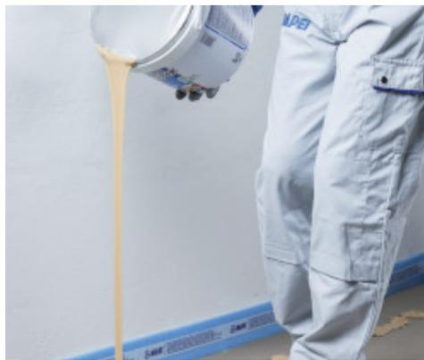
Bassa viscosità per una facile applicazione sul sottofondo
