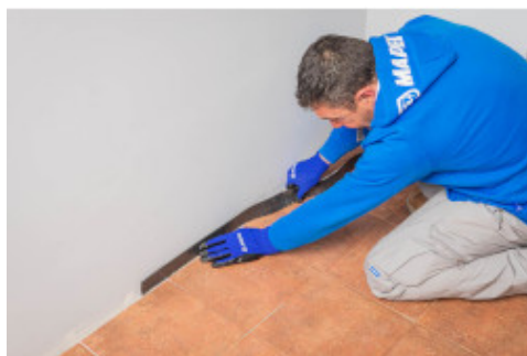
Applicare lungo il perimetro del locale il nastro adesivizzato Mapesonic Strip
