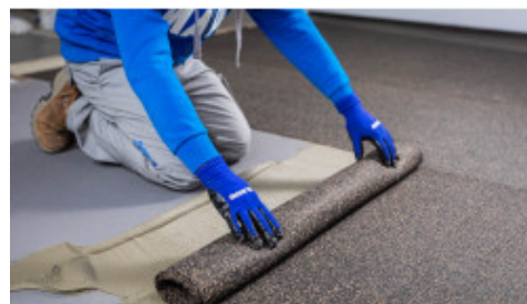
Distendere i rotoli di Mapesonic CR lungo le superfici interessate avendo cura di accostare perfettamente i teli l'uno all'altro
