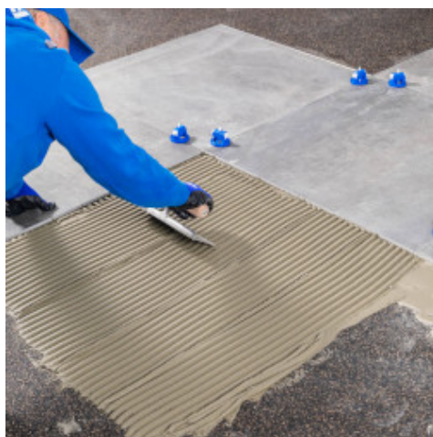
Su supporto adeguatamente preparato, procedere alla stesura dell'adesivo per l'incollaggio dei teli fonoisolanti
