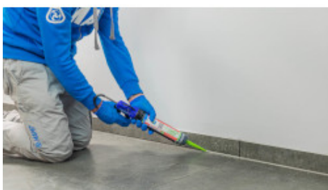
Sigillare lo spazio ricavato tra zoccolatura e pavimento con un idoneo sigillante elastico della gamma Mapei
