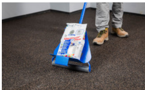
Massaggiare la superficie con un rullo rigido o con una spatola piana, partendo dal centro verso l'esterno
