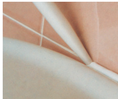
Sigillatura di sanitari
