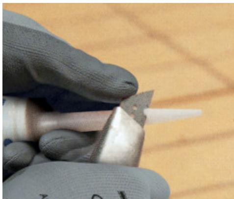
Tagliare l'ugello in base alle dimensioni del giunto
