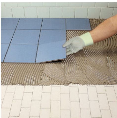
Posa di monocottura su parete in blocchi di cemento cellulare espanso
