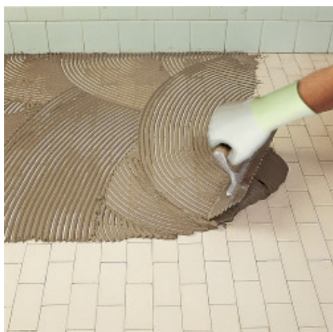
Posa di marmo prelevigato a pavimento
