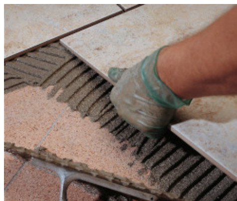
Sovrapposizione di un rivestimento in monocottura su marmette esistenti
