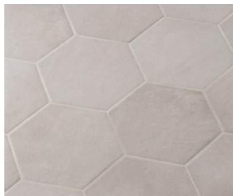
Pavimentazione stuccata con Keracolor FF
