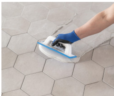
Stesura di Keracolor FF con spatola MAPEI
