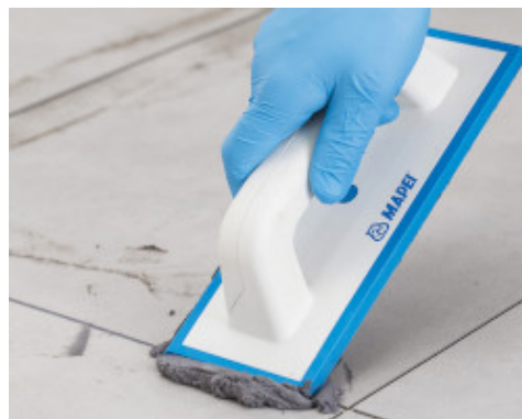
Stuccatura delle fughe con Flexcolor 4 LVT
