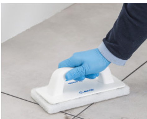
Rimozione con Scotch-Brite® di eventuali residui riscontrabili a distanza di qualche ora
