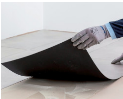
Incollaggio di LVT in piastre con Ultrabond Eco 4 LVT
