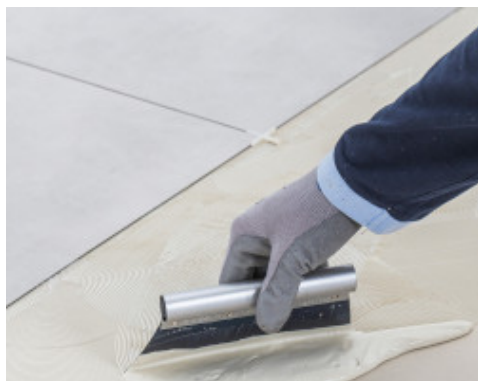
Stesura di Ultrabond Eco 4 LVT ed incollaggio degli LVT in piastre a fuga larga con distanziatori
